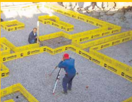
Valmismuotin avulla myös monimuotoisen rakennuksen antura on mahdollista tehdä ja valaa valmiiksi päivässä.
