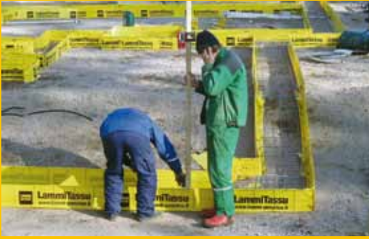
Valmismuotit asennetaan tasatulle ja tiivistetylle maapohjalle.
