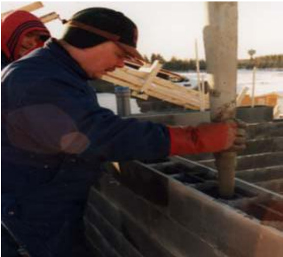
Рис. 8. На конце шланга бетононасоса рекомендуется использование футорки для того, чтобы облегчить заливку бетонной массы внутрь стены.
