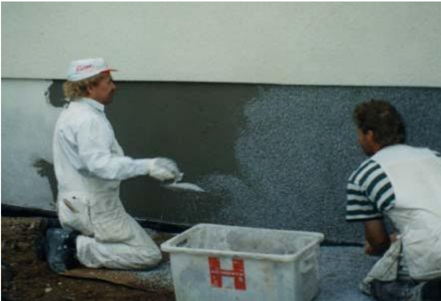
Рис. 11. Крошка набрасывается на выровненную поверхность, покрытую минеральным раствором.
