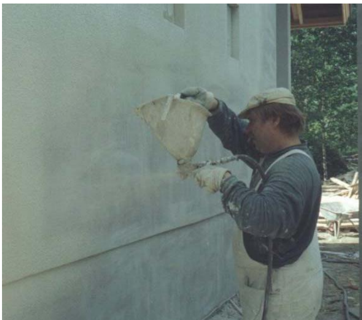
Рис.12. Процесс оштукатуривания требует точности. На выровненную поверхность распыляется цементный раствор, содержащий цветные добавки.
