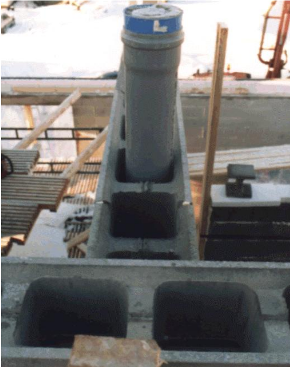
Рис. 7. Внутри стены помещается трубы даже большого диаметра.
