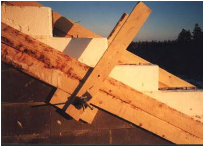
Рис. 4. Опалубка фронтона
