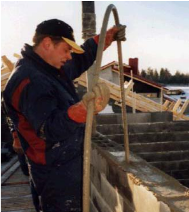
Рис. 9. Для уплотнения используется вибробулава. Для достижения хорошего результата работать вибробулавой надо в спокойном темпе.
