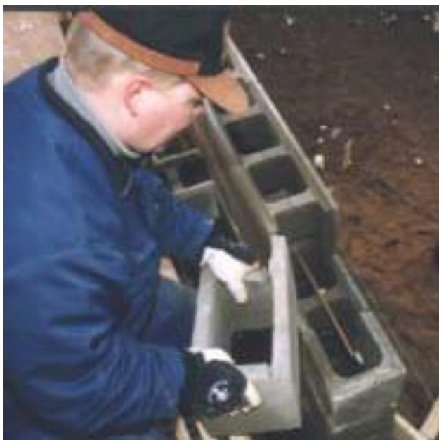
Рис. 2. Кладка торцов стен торцевыми блоками выполняется без сложностей. Торцевая часть на время заливки бетоном тщательно укрепляется.
