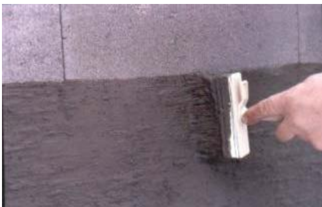
Рис. 10. Однослойное оштукатуривание поверхности конструкции цементным раствором.
